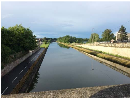
PHOTO 64 : CANAL DE SAINT-QUENTIN - T&P, JUIN 2016
