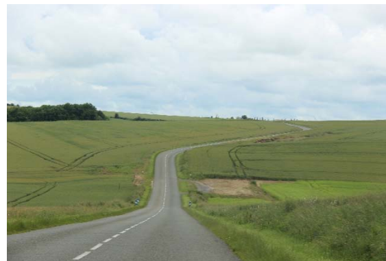
PHOTO 79 : LA ROUTE DEPARTEMENTALE 283 - T&P, JUIN 2016
