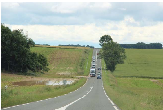
PHOTO 80 : LA ROUTE DEPARTEMENTALE 8 - T&P, JUIN 2016
